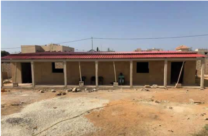
Ein neues Gebäude entsteht
